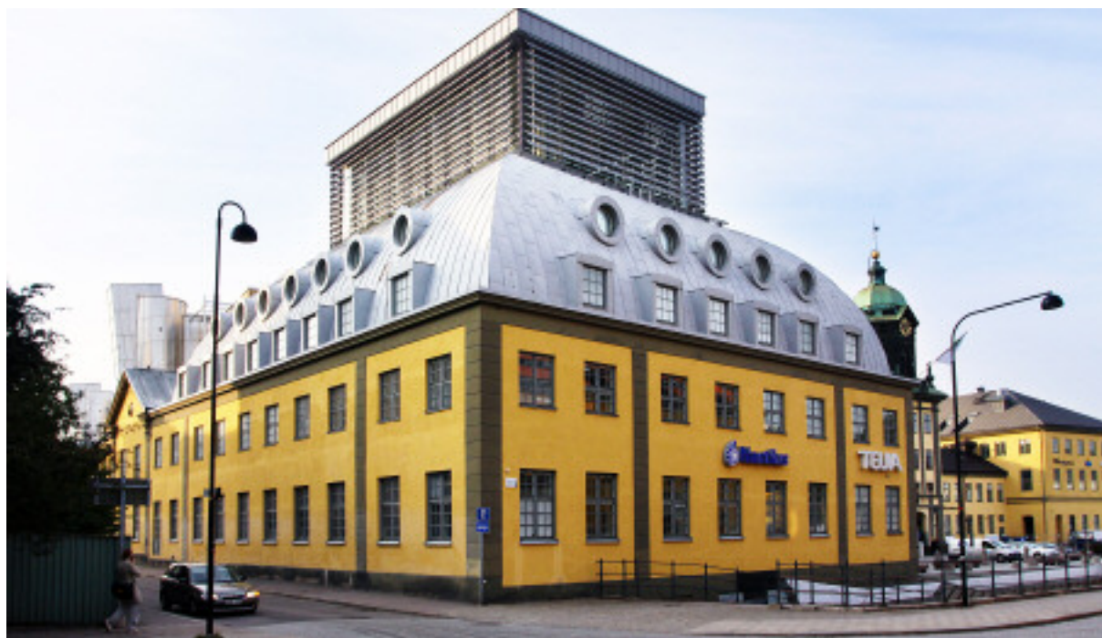
Kvarnholmen 4 i Norrköping: Fastigheten Kvarnholmen 4 i Norrköping, med bl a Telia som hyresgäst, ingår i förvärvet av den fastighetsportfölj om totalt 37 fastigheter som Klöveren tillträdde den 1 oktober 2010.
